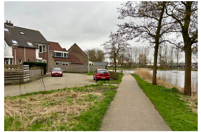
Sjaermastate, groen blauw raamwerk met padenstructuur
